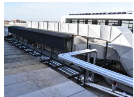
Se incorporó 1 km de aislamiento térmico a las cañerías de agua caliente.
