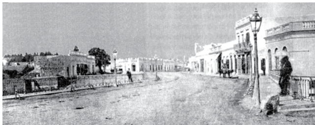
Puente del Paso Molino
