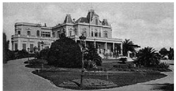
Fig. 3. Palacio Unzué o "quinta Unzué". Abarcaba la manzana ubicada entre las calles Avenida Alvear (hoy Avenida del Libertador), Agüero, Las Heras y Austria. Mariano Unzué y su esposa Mercedes Baudrix lo hicieron construir en 1887 para residencia de verano, pero luego la ocuparon a permanencia. Los jardines habían sido diseñados y realizados por Rubén Darío y aún puede verse de ellos un inmenso gomero sobre la calle Austria. En 1937 fue expropiada por el presidente Agustín P. Justo para residencia presidencial y el primer presidente que la utilizó como tal fue Roberto Ortiz. El Gral. Juan Domingo Perón la ocupó en sus dos primeros períodos de gobierno entre los años 1946 y 1955, fecha en que fue derrocado. En esta residencia el Dr. George Pack hizo el examen clínico bajo anestesia a Evita sin que ella tomara conocimiento del mismo, el Dr. James L. Poppen la intervino también sin ella saberlo y allí fue donde finalmente falleció el 26 de julio de 1952. El gobierno militar que derrocó a Perón ordenó su demolición y entre 1962 y 1992 se construyó en el predio la Biblioteca Nacional de la República Argentina.
